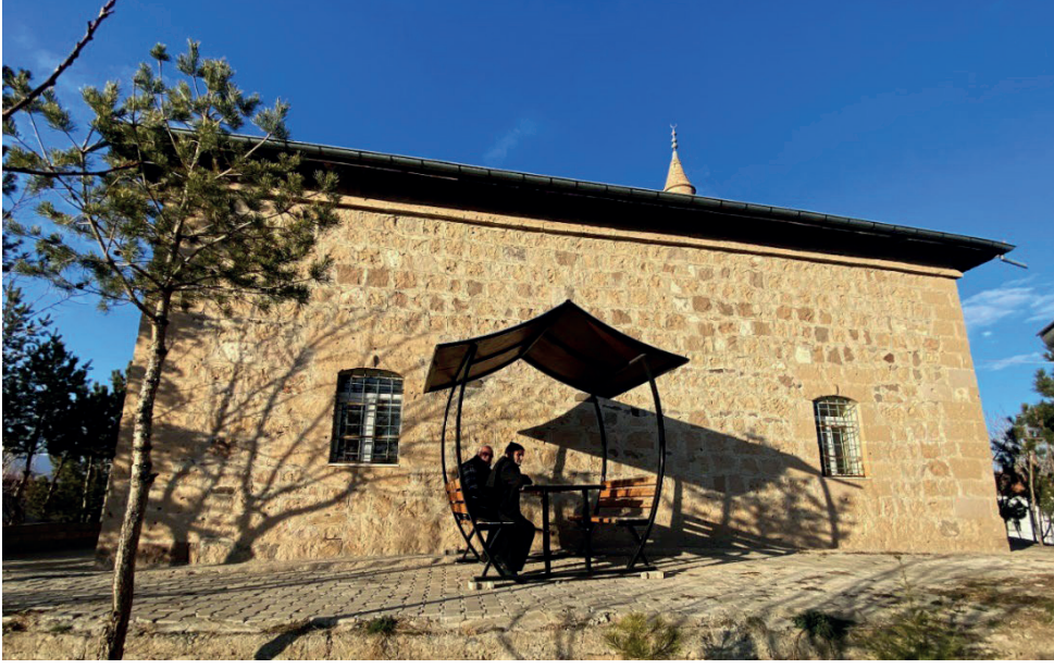
Görsel 76: Caminin Güney Cephesi
