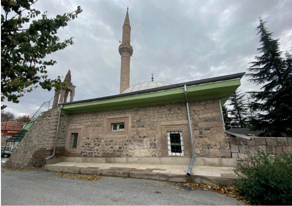
Görsel 17: Caminin Kuzey Cephesi
