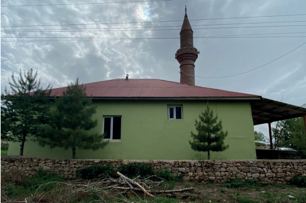
Görsel 40: Doğu Cephesi
