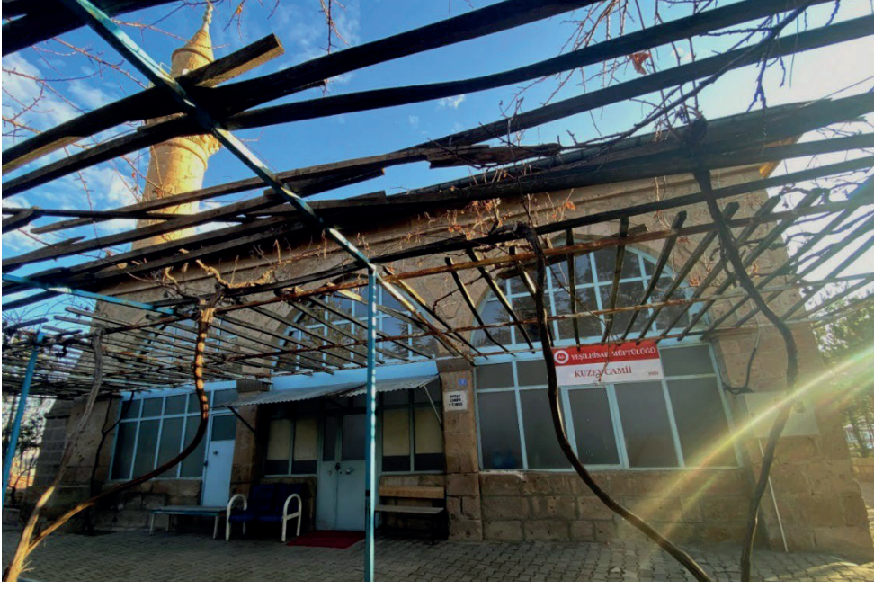
Görsel 74: Caminin Kuzey Cephesi
