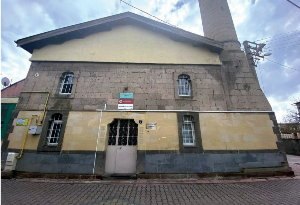
Grsel 46: Kuzey Cephesi
