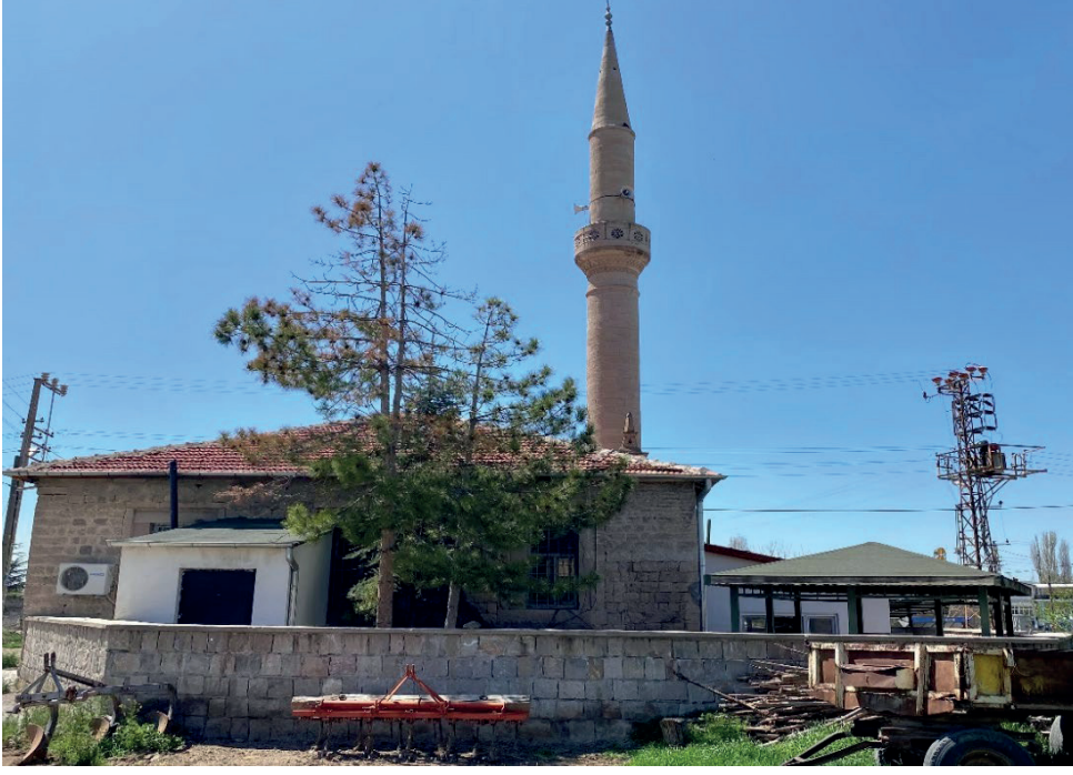
Görsel 5: Caminin Batı Cephesi
