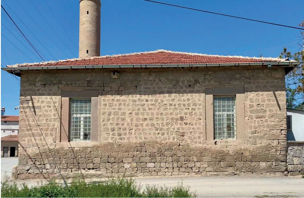
Görsel 4 : Caminin Güney Cephesi
