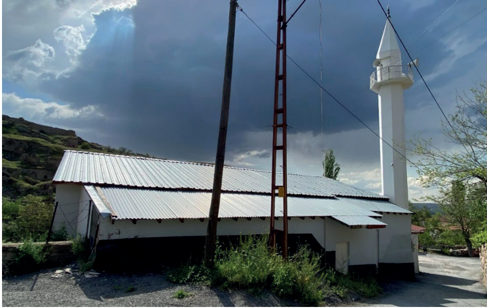
Görsel 68: Doğu Cephesi
