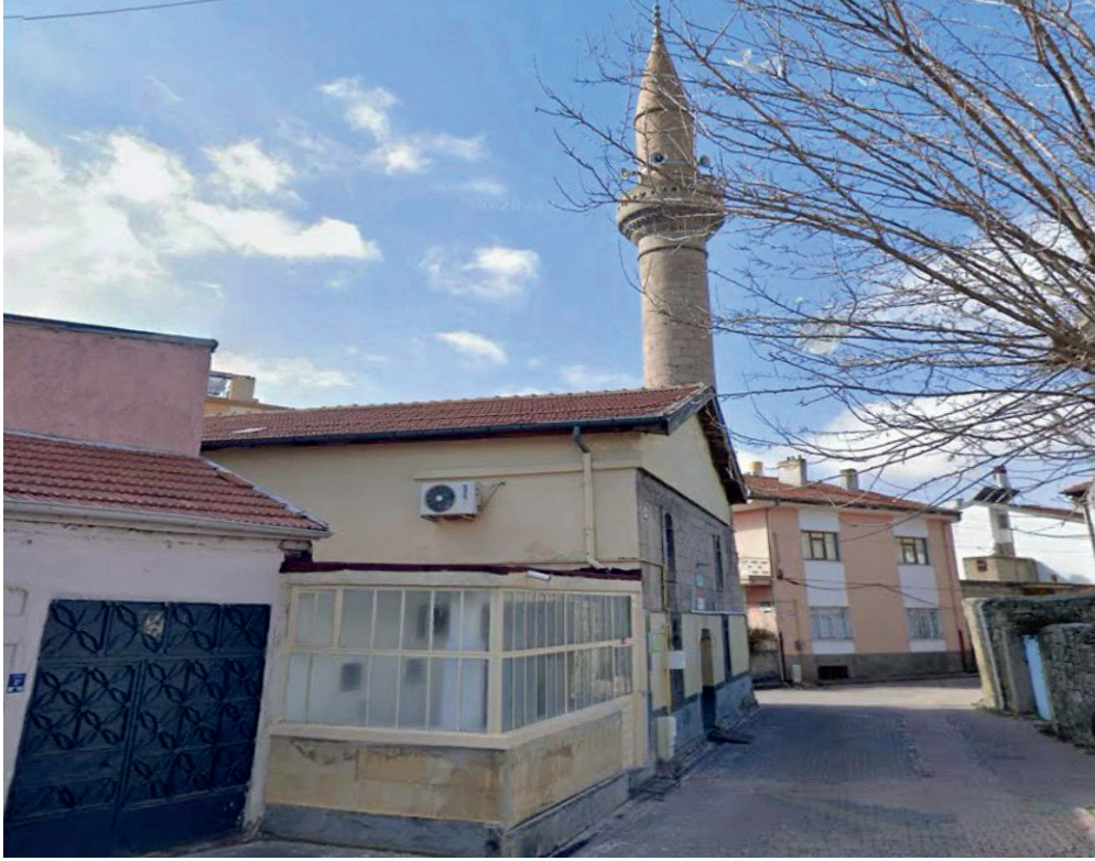
Görsel 48: Doğu Cephesi
