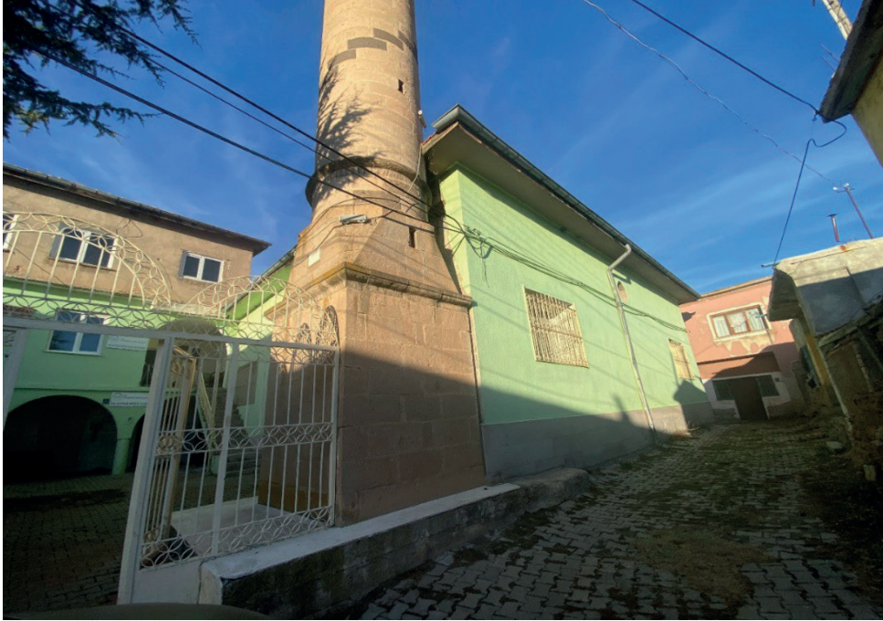
Görsel 26: Caminin Güney Cephesi
