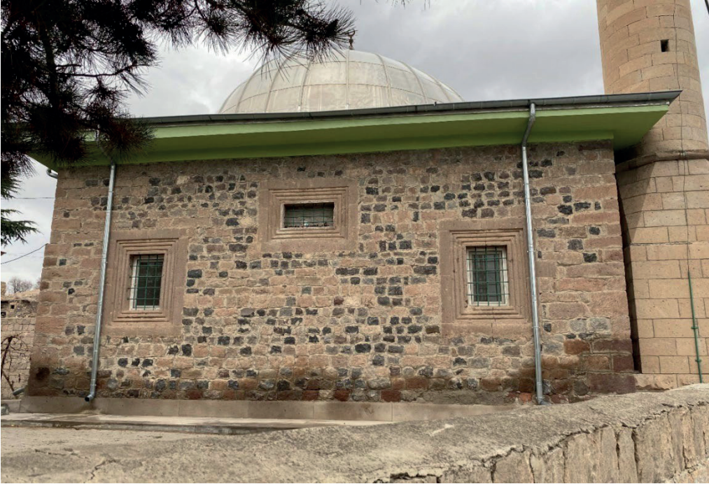
Görsel 15: Caminin Güney Cephesi
