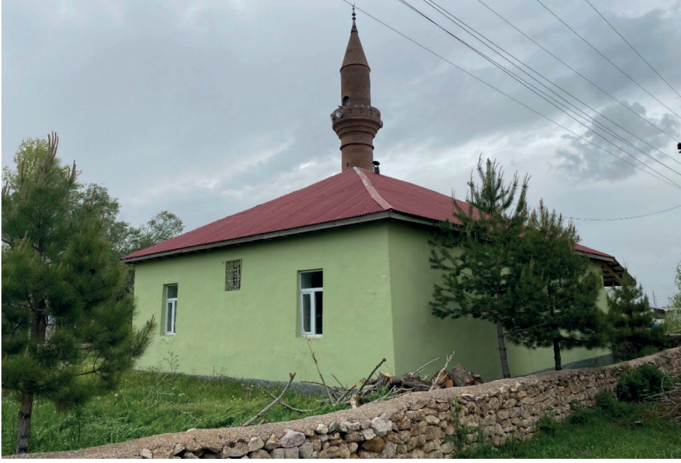
Görsel 39: Güney Cephesi
