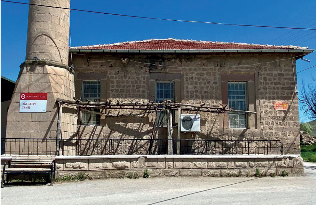
Görsel 3: Caminin Batı Cephesi
