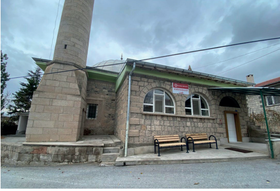
Görsel 14: Caminin Batı Cephesi
