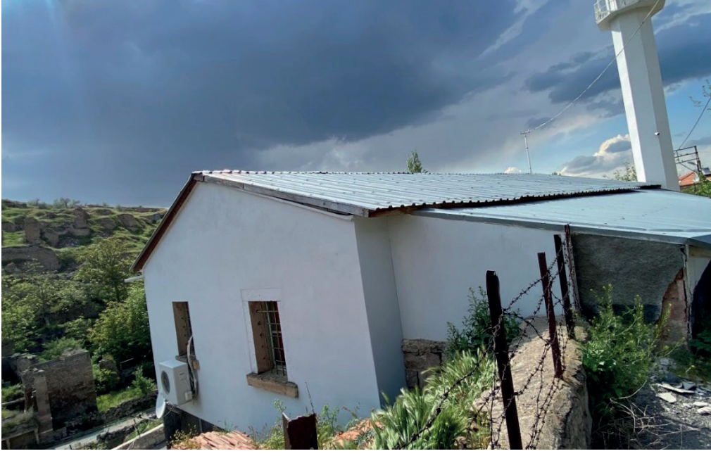
Görsel 67: Güney Cephesi
