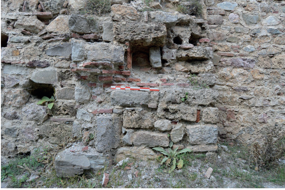
Görsel 29: Güneydoğu Kapı batı duvarındaki almaşık duvar tekniğinden detay (Yazar)
