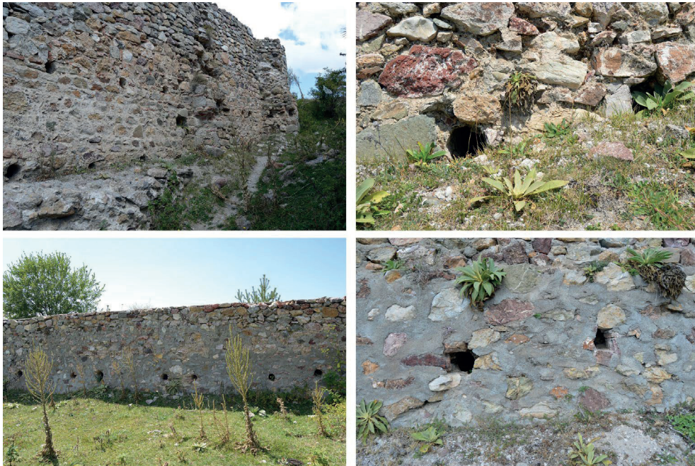
Görsel 28: Batı Kapı, B20 ve İç Kale duvarlarındaki ahşap hatıl boşlukları (Yazar)
