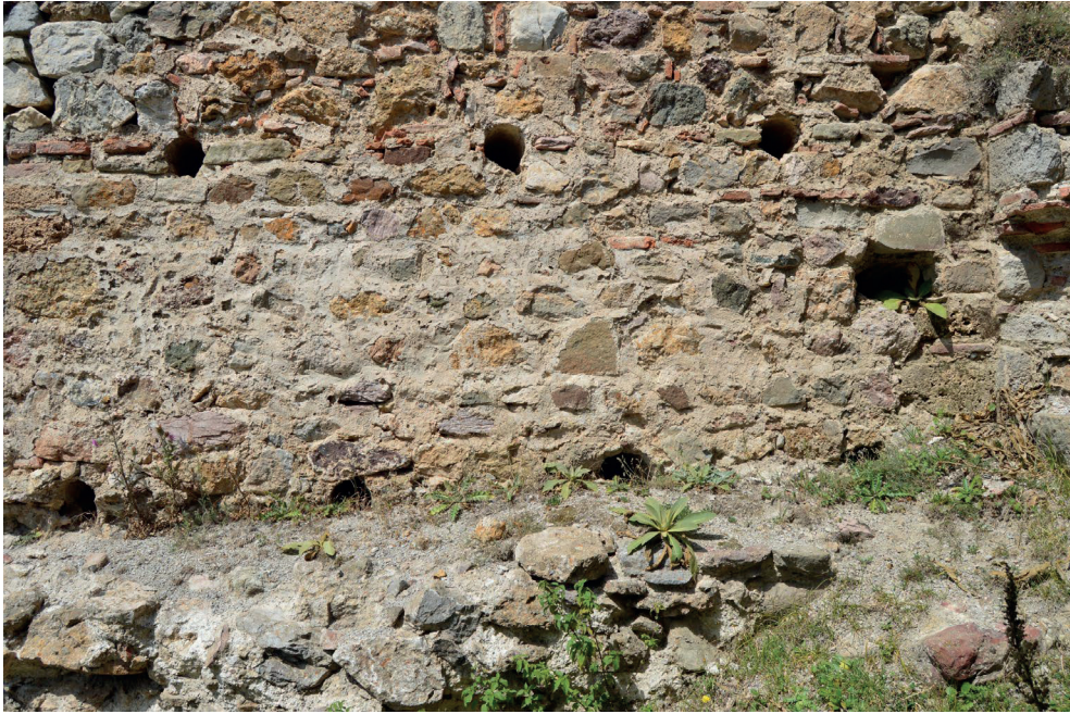
Görsel 30: Güneydoğu Kapı batı duvarındaki düzensiz kasetleme tekniğinden detay (Yazar)
