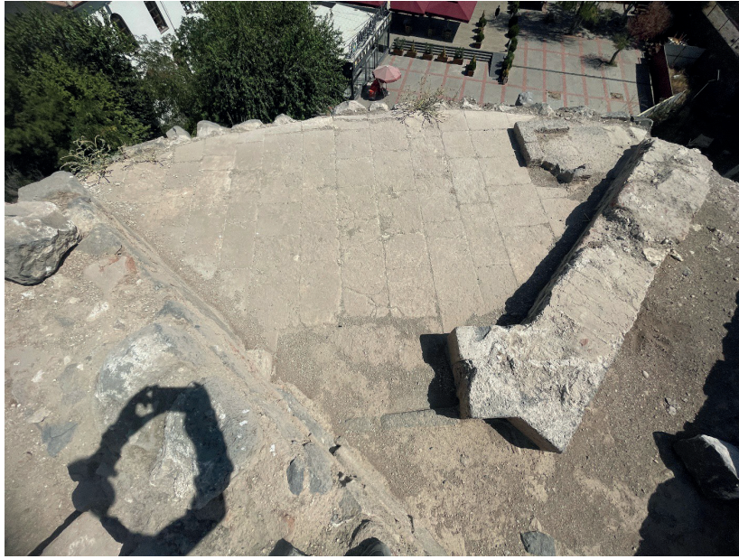
Görsel 13 -Mevcut döşeme taşları
