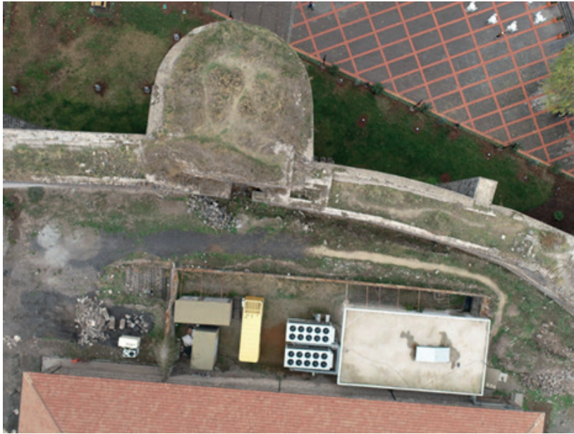
Görsel 7- 76 Nolu Burç Kazı öncesi durumu
