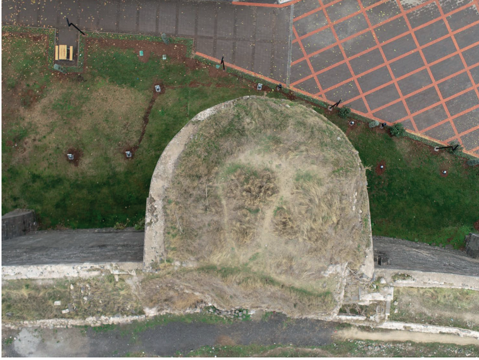
Görsel 8 - 76 Nolu Burç Kazı öncesi durumu
