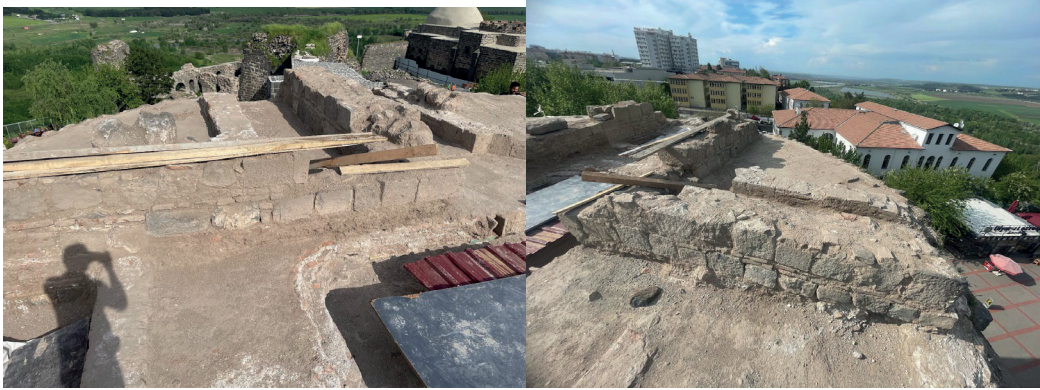
Görsel 19- Devşirme malzeme kullanılarak "L" şeklinde yapılan duvarlar
