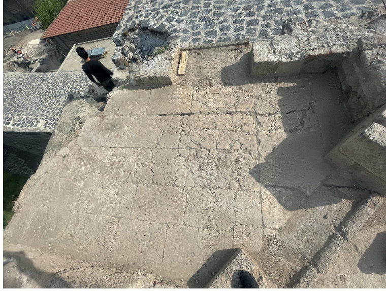
Görsel 12- Mevcut döşeme taşları
