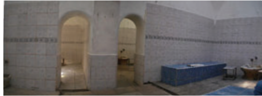
Foto. 19: Korkut Hamamı, sıcaklık.
