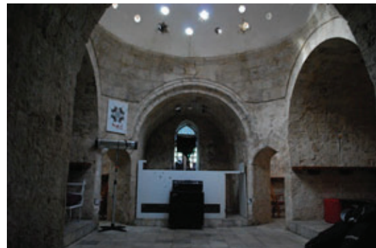
Foto. 16: Cafer Paşa Hamamı, sıcaklık.
