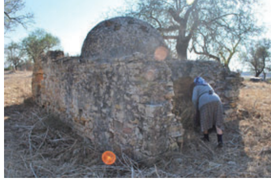
Foto. 33: Hisarköy Hamamı, su deposu.
