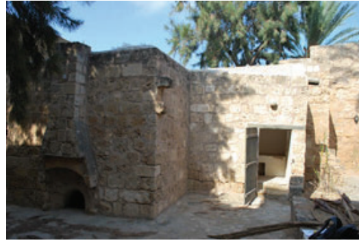
Foto. 34: Şömineli Ev Hamamı, doğu cephe.
