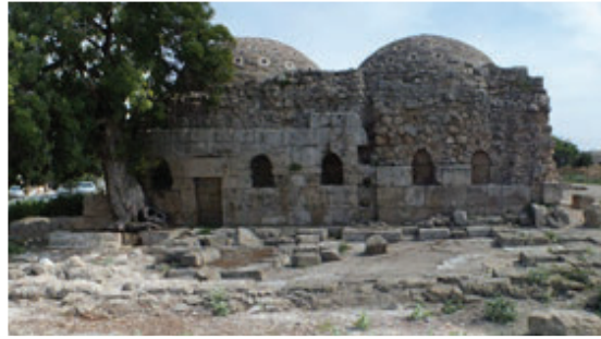
Foto. 37: Hasan Ağa Tekkesi Hamamı, kuzey cephe.
