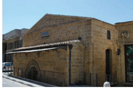
Foto. 1: Büyük Hamam, kuzey cephesi.
