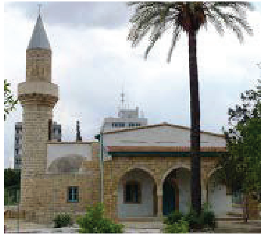
Resim 14- Bayraktar (Şehit Alemdar) Camii (Çağnan'dan)
